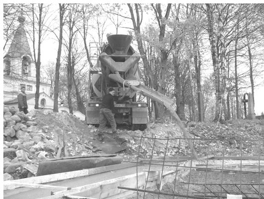
Рис. 12. Заливка фундамента
